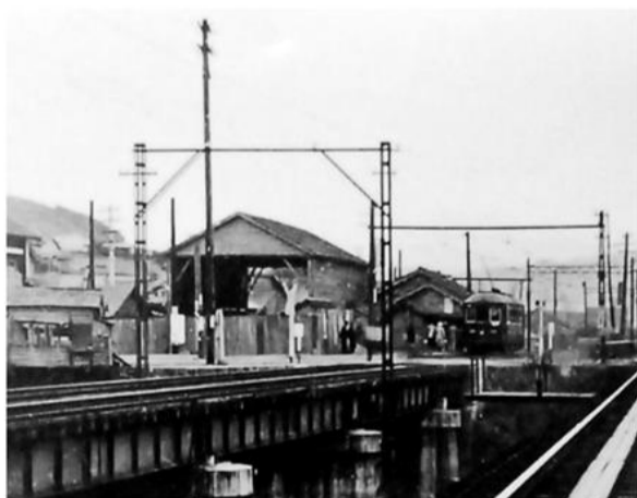
大橋鉄橋付近
